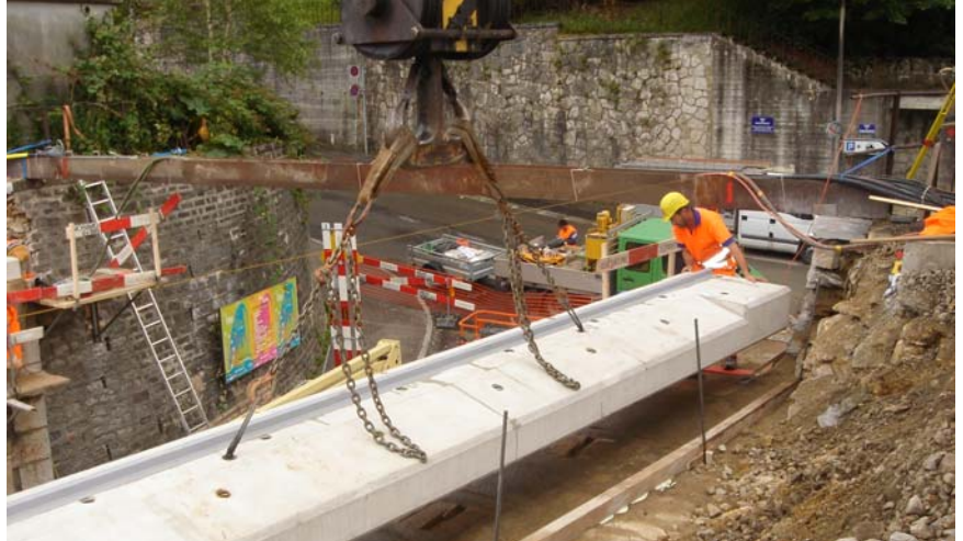
Pose des éléments du PI (week-end)
