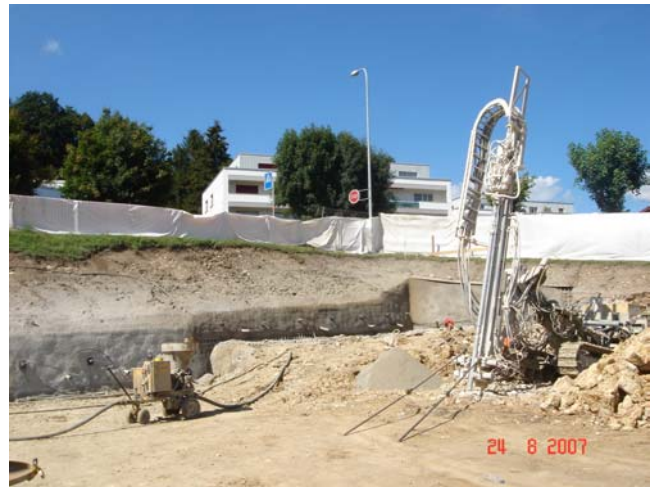
Enceinte de fouille et terrassement aile est
