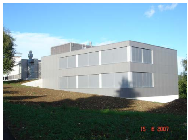
Aile ouest terminée
