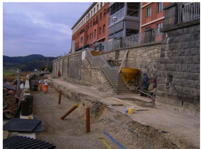
Remblayage sur canalisations
