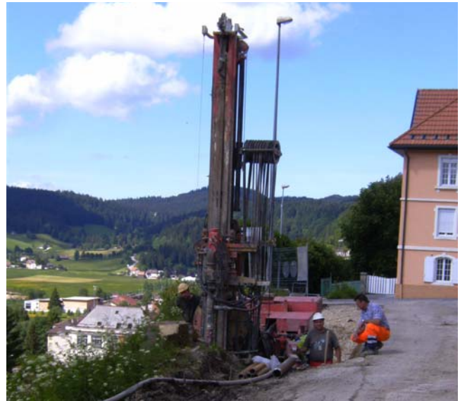
Forage des micropieux
