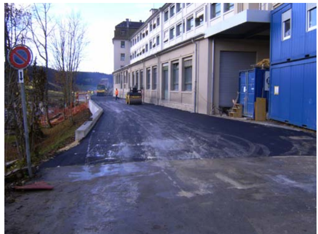
Pose de l'enrobée
