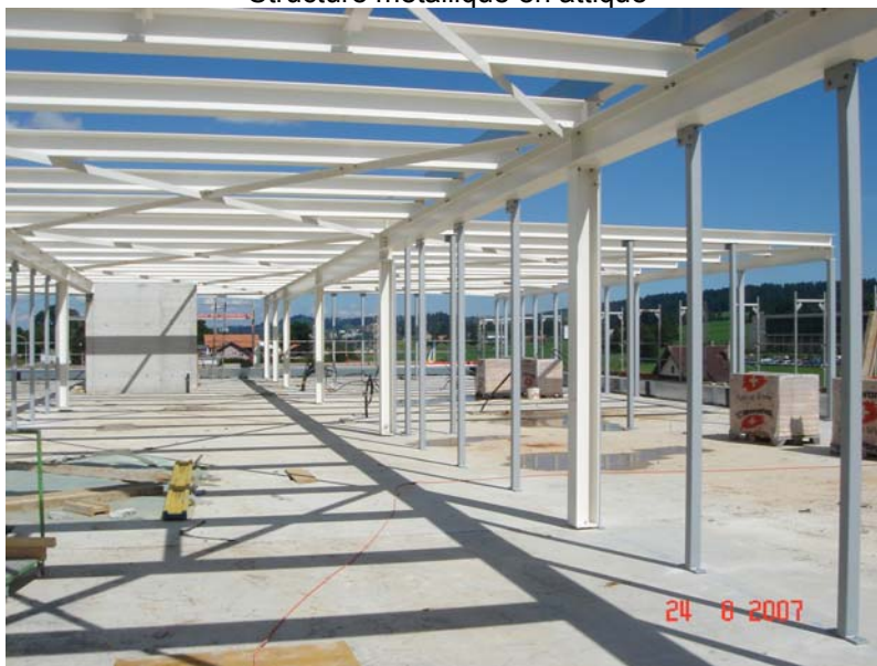
Structure métallique en attique
