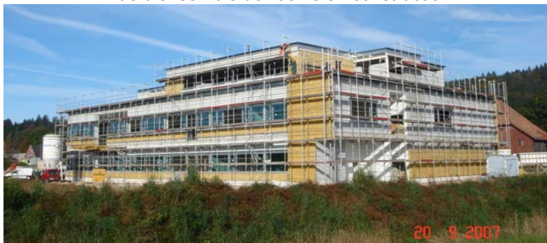
Vue d'ensemble de l'usine en construction
