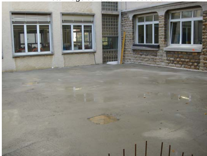
Bétonnage dalle sur 3 ème sous-sol
