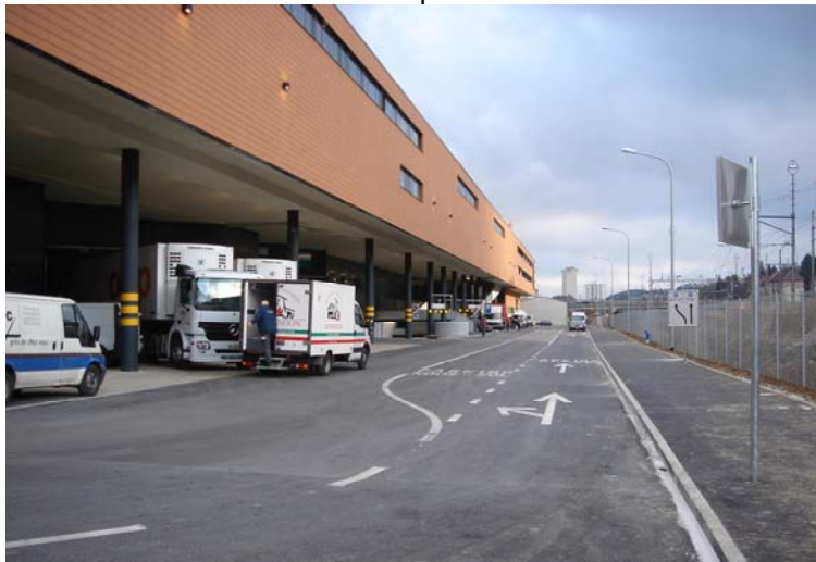
Rue des Entrepôts terminée
