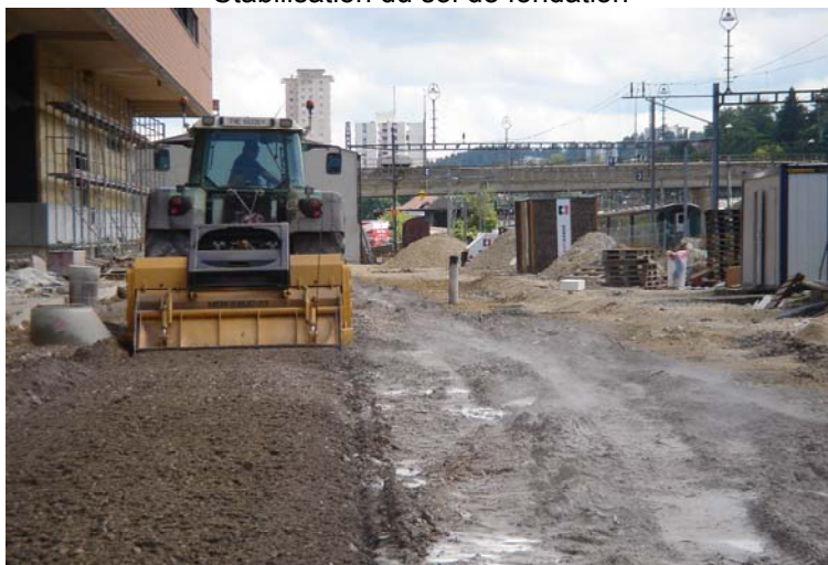
Stabilisation du sol de fondation
