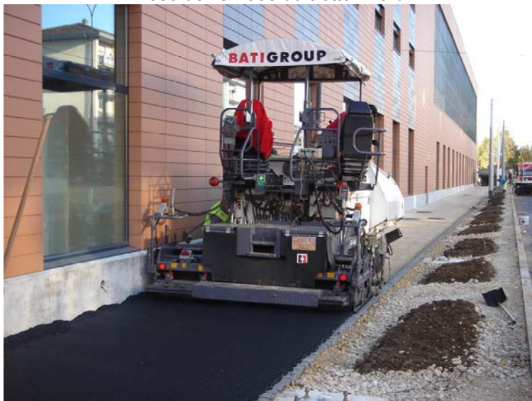
Pose de l'enrobé du trottoir nord
