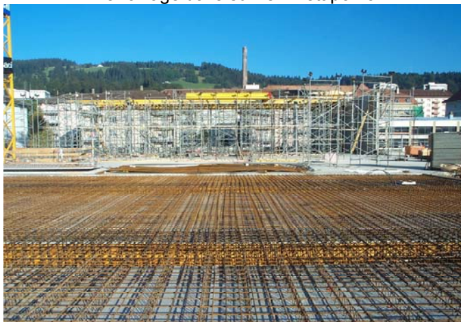
Ferrillage dalle sur rez – étape 13
