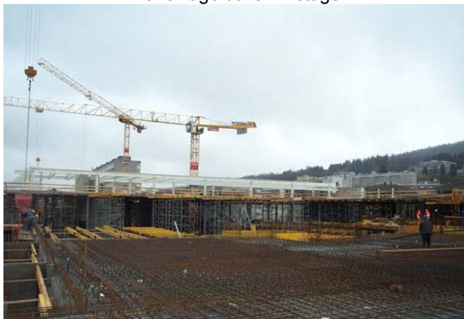
Ferrillage dalle 1 er étage
