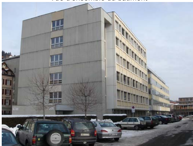
Vue d'ensemble du bâtiment
