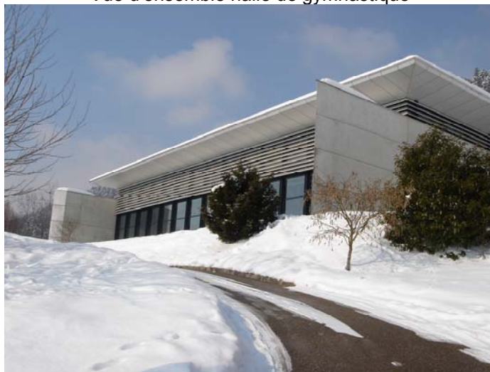
Vue d'ensemble halle de gymnastique
