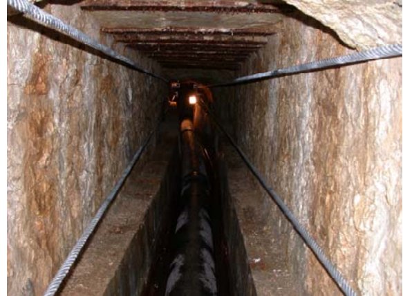
Tunnel de Jogne et câbles d'ancrage
