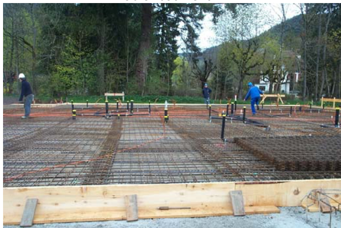
Radier bâtiment n°1
