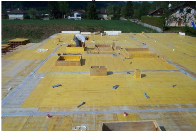
Coffrage de dalle
