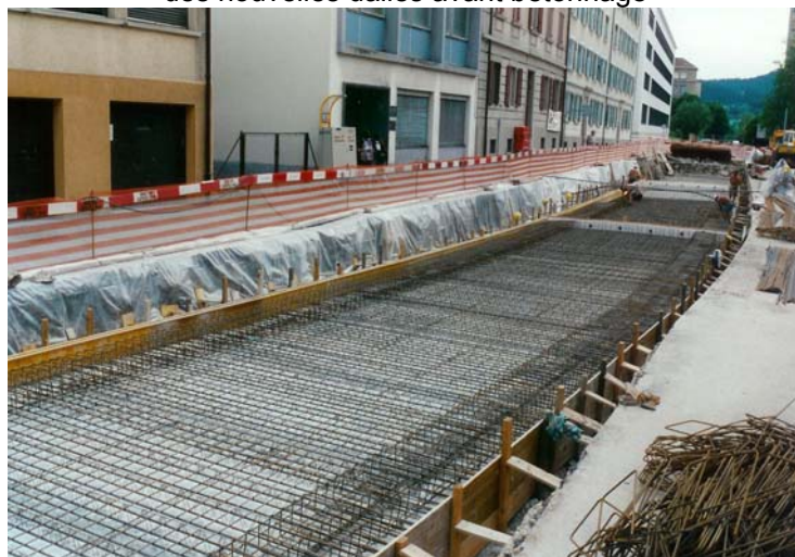
Prédalles (coffrage perdu) et armature des nouvelles dalles avant bétonnage
