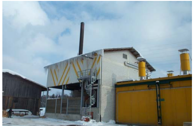
Chaufferie à bois
