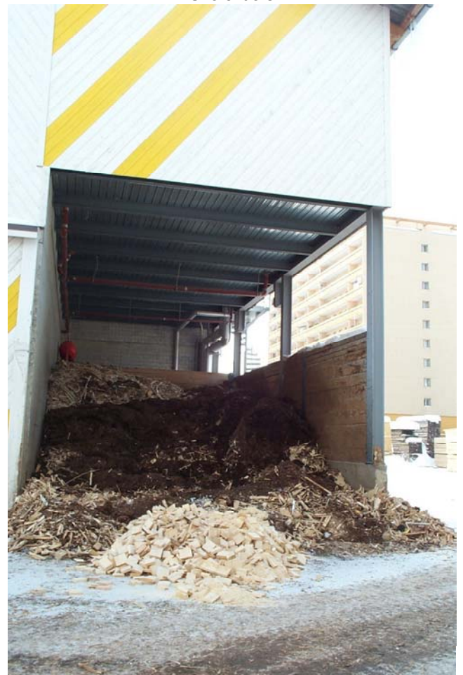
Silo à bois
