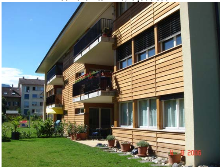
Batiment B terminé, façades Nord et Ouest
