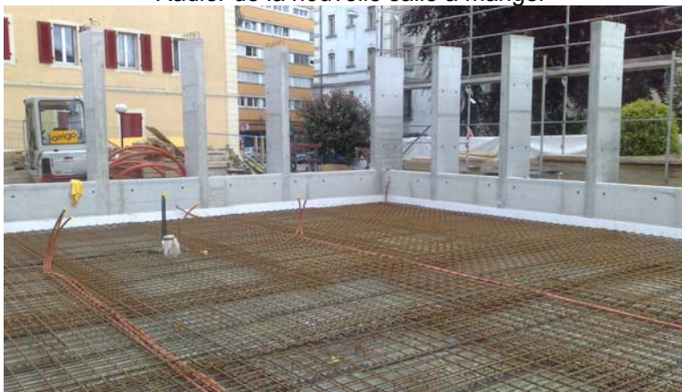
Radier de la nouvelle salle à manger
