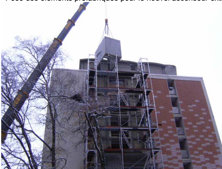
Pose des éléments préfabriqués pour le nouvel ascenseur ext.
